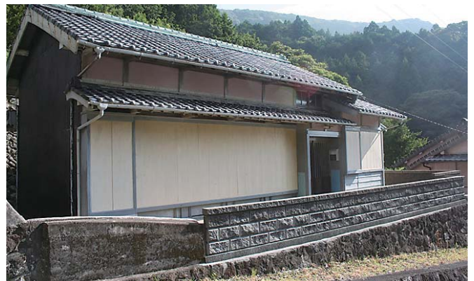
須野のきれいな空き家
